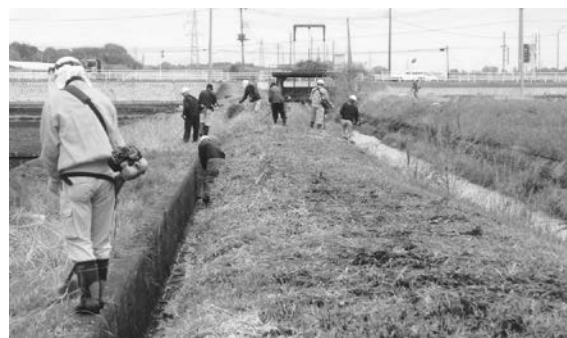
水路の草刈り、泥上げ
