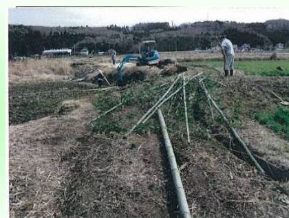
法面崩落箇所の掘削
