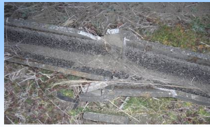
地震により受台から落下した水路
