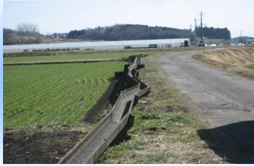
地震により受台から落下した水路
