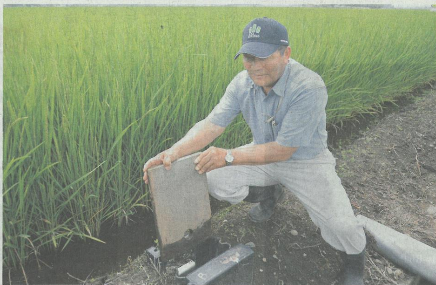
田んぼの排水口に弁を設置し、直径約4センチの穴が空いた板を挟んで排水量を調節する
