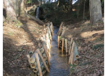
白松杭と竹を使用した竹柵設置(27 年 2 月)
